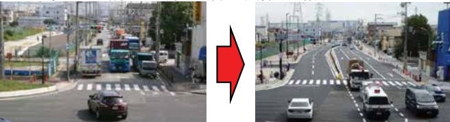
街路事業による渋滞交差点の解消 (H28年9月完成) 都市計画道路尼崎宝塚線 武庫川交差点(尼崎市)
