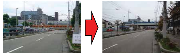
連続立体交差事業による開かずの踏切の解消 (H29年3月高架切替完了) 阪神電鉄鳴尾駅付近(西宮市)
